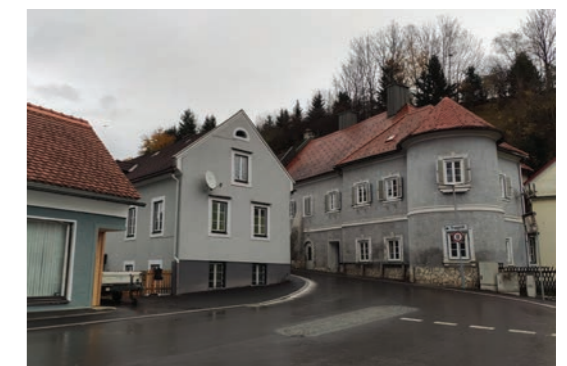
Abb. 4.3.13: Haus in der Friedhofstraße, das abgerissen wird. Eigene Aufnahme
