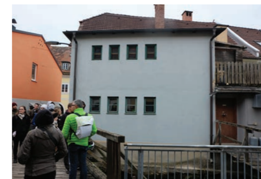
Abb. 4.3.12: Haus in der Hauptstraße, das abgerissen wird. Eigene Aufnahme
